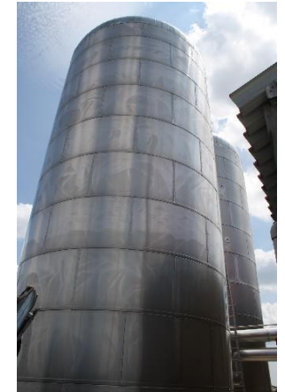
zwei Pufferspeicher mit je 100.000 Liter Volumen
